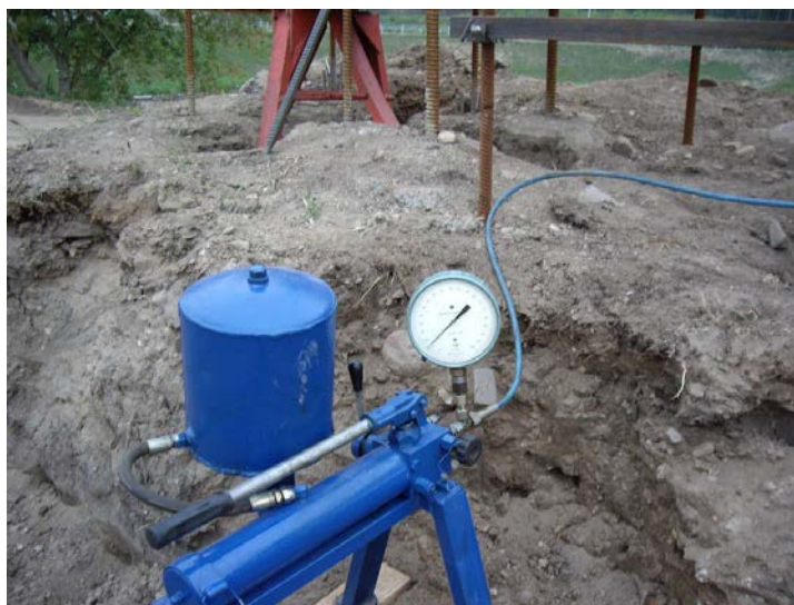
1.3 pav. Rankinė hidraulinė siurblinė
